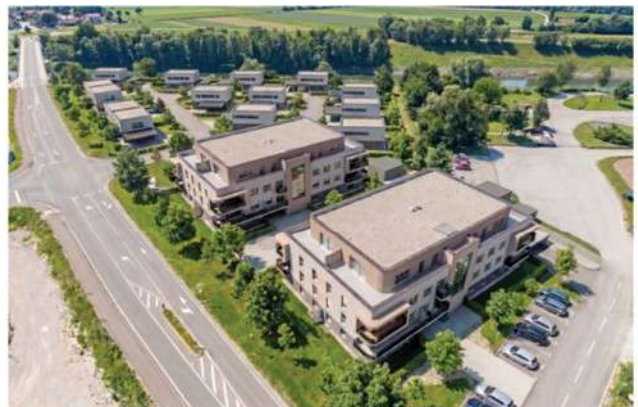
Stanovanja bodo opremljena z lastno toplotno črpalko, talnim ogrevanjem, lokalnim prezračevanjem in troslojnimi okni z zunanji žaluzijami na električni pogon. Foto: Soseska Zlatoličje
